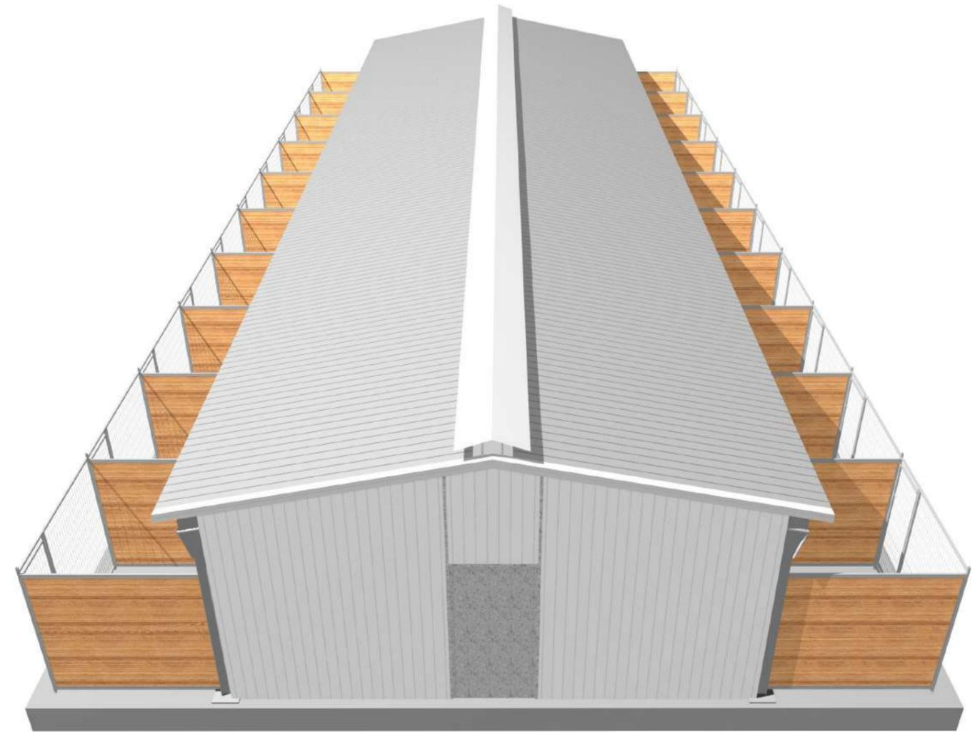
**Cubierta de panel sándwich** (chapa-poliuretano-chapa) de 30 mm. de espesor, **con** **cumbra móvil** para facilitar la **ventilación interior**.
